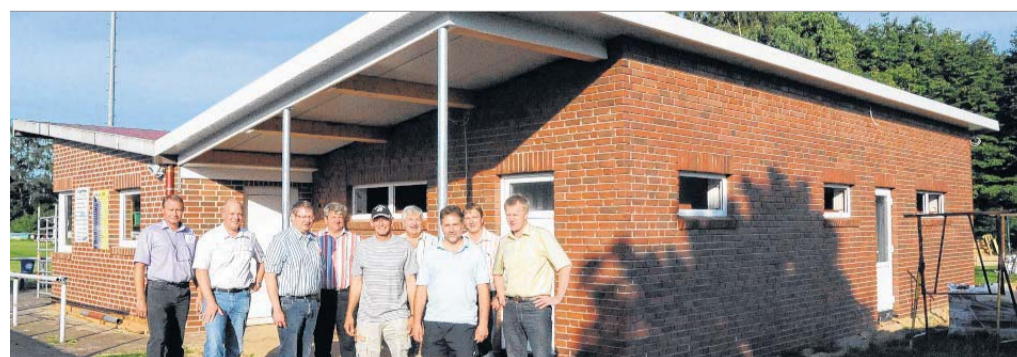
Besuch auf der Baustelle: Über den Stand der Arbeiten informierten führende Kräfte des SuS Rhede die Mitglieder des Ausschusses für Soziales, Jugend und Sport. Foto: Gerd Schade
