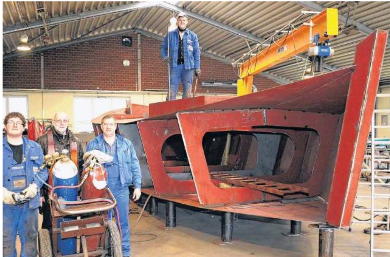
Geschweißt werden die Elemente für den Rumpf in der Metallwerkstatt der Johannesburg. Unser Bild zeigt Dennis Schepers (links) und Johann Tissen (auf dem Schiff), angehende Konstruktionsmechaniker auf der Meyer Werft, zusammen mit Ludger Stukenborg, Vorsitzender Papenbörger Hus, und Heinz Wotte, Ausbilder auf der Johannesburg. Fotos: Klaus Dieckmann
